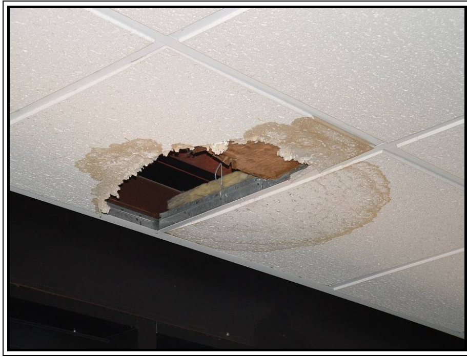
Fig. 6 e fig. 7 – Effetti delle infiltrazioni nei locali interni
