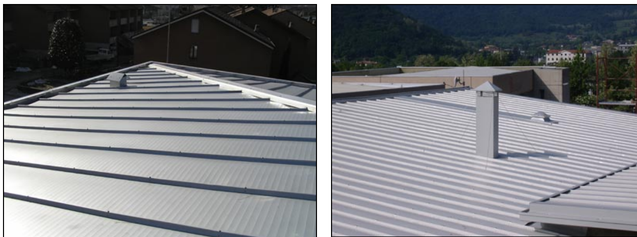
Fig. 19: coperture metallica impostata su falde inclinate
