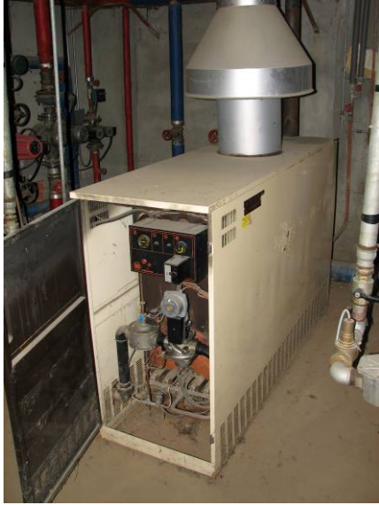
Fig. 9, 10: Generatore di calore e rete di distribuzione del calore.
