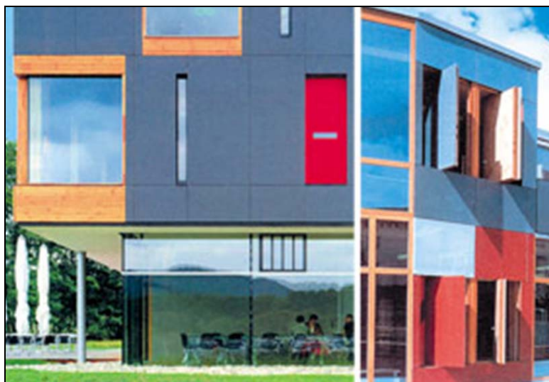
Fig. 14: possibili colorazioni del rivestimento in fibrocemento
